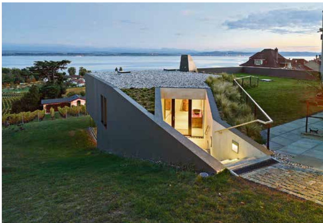
Pour l'architecte neuchâtelois Andrea Pelati, l'enjeu était de créer une habitation la plus discrète possible.
